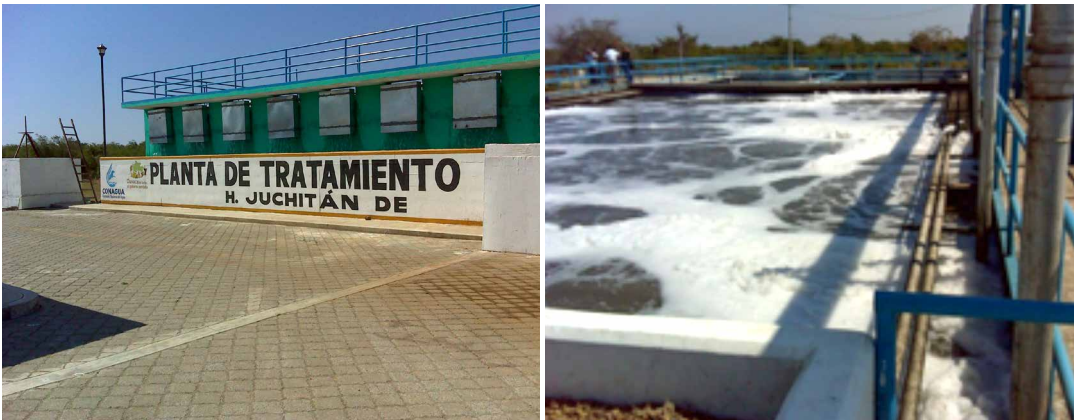
Foto 5. Planta de tratamiento de aguas residuales en Juchitán de Zaragoza en 2012.
